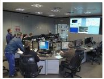
SALA DE CONTROL
