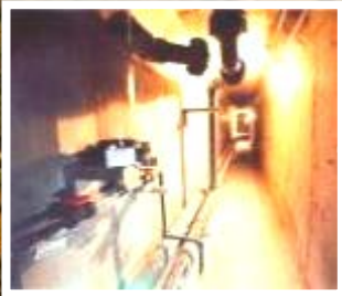
RED DE CONTROL DE INFILTRACIONES
